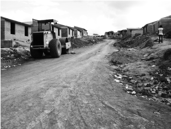
CONSTRUCCIÓN DE LA PRIMERA CIUDAD RURAL, NUEVO JUAN DE GRIJALVA (2009).
